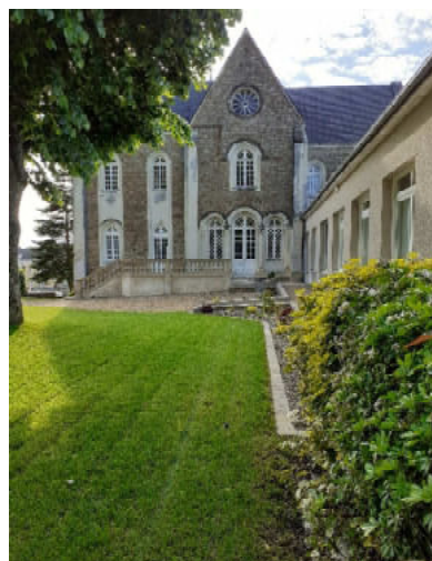
Parc de la mairie après travaux
